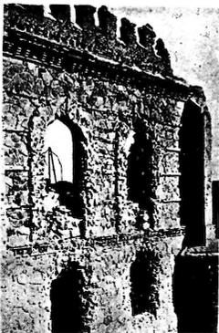
Las ventanas que se ven en el grabado anterior, aumentadas. No sufrieron la acción de la artillería, pero su estado da idea de los destrozos que puede causar el fuego de la fusilería y de las ametralladoras.
